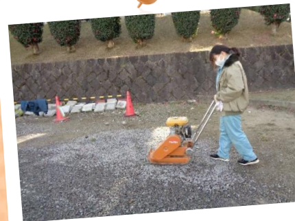
ダンパーという道具で 地面の締固め（施工）を しています
