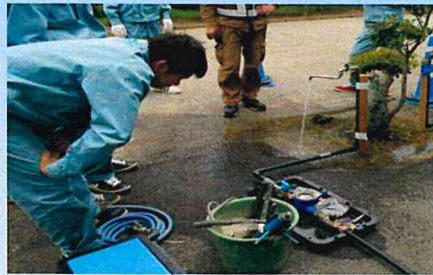
水道管設置体験
