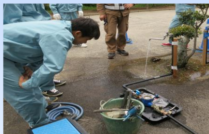
水道管設置体験
