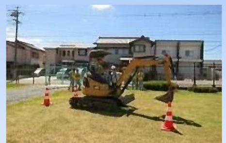
〔小型車両系建設機械〕
